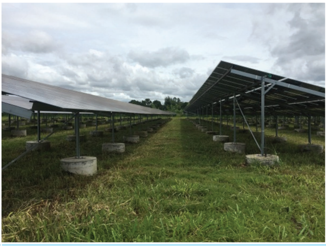
ดูแลรักษาความสะอาดใต้แผงเซลล์แสงอาทิตย์
